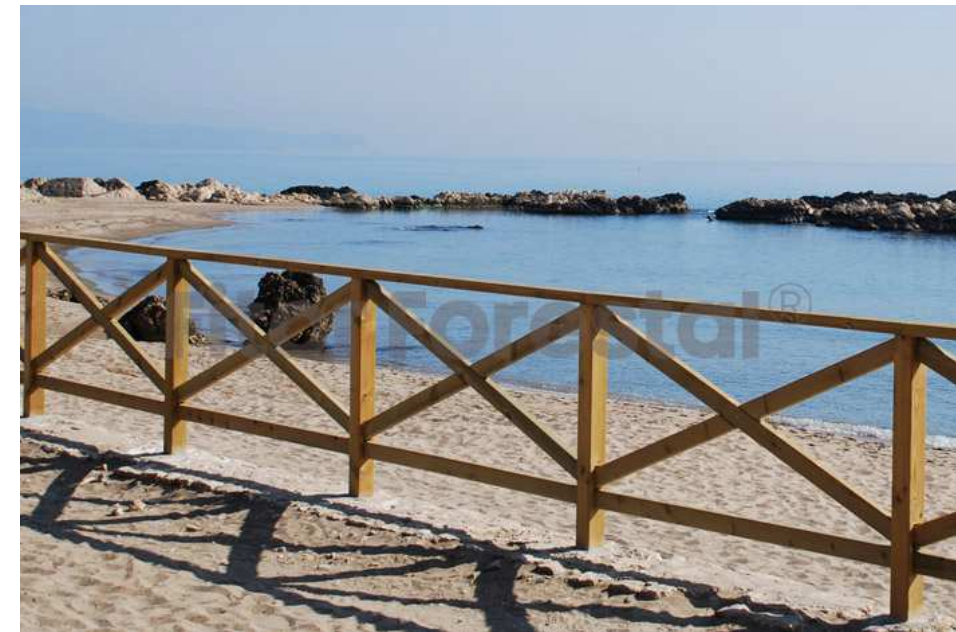
Figura 2: Imatge de barana ja instal·lada
