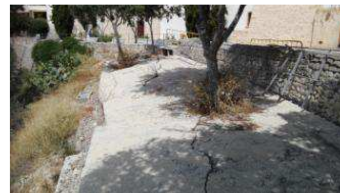
Paviment esquerdat degut a la mobilització del terraplè
