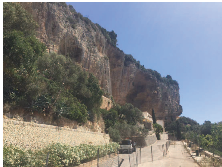
FOTO 1: Vista parcial de la zona d'estudi
