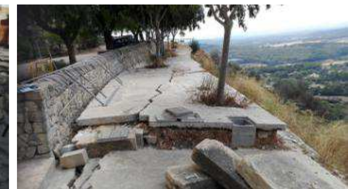
Paviment esquerdat degut a la mobilització del terraplè
