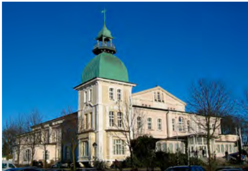
Vista exterior de la Shützenhalle de Lüdenscheid
