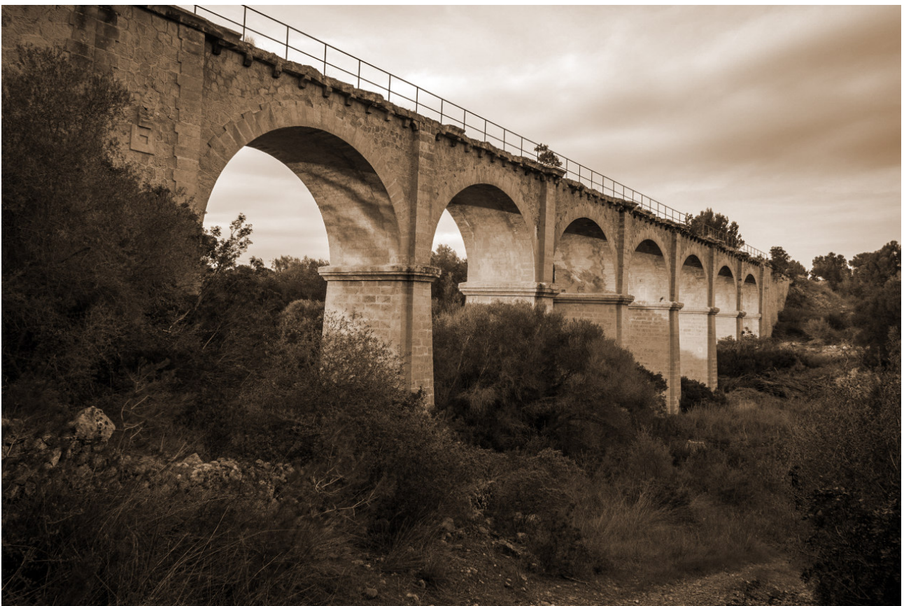
Pont. Fotografia d'Antoni Montserrat
