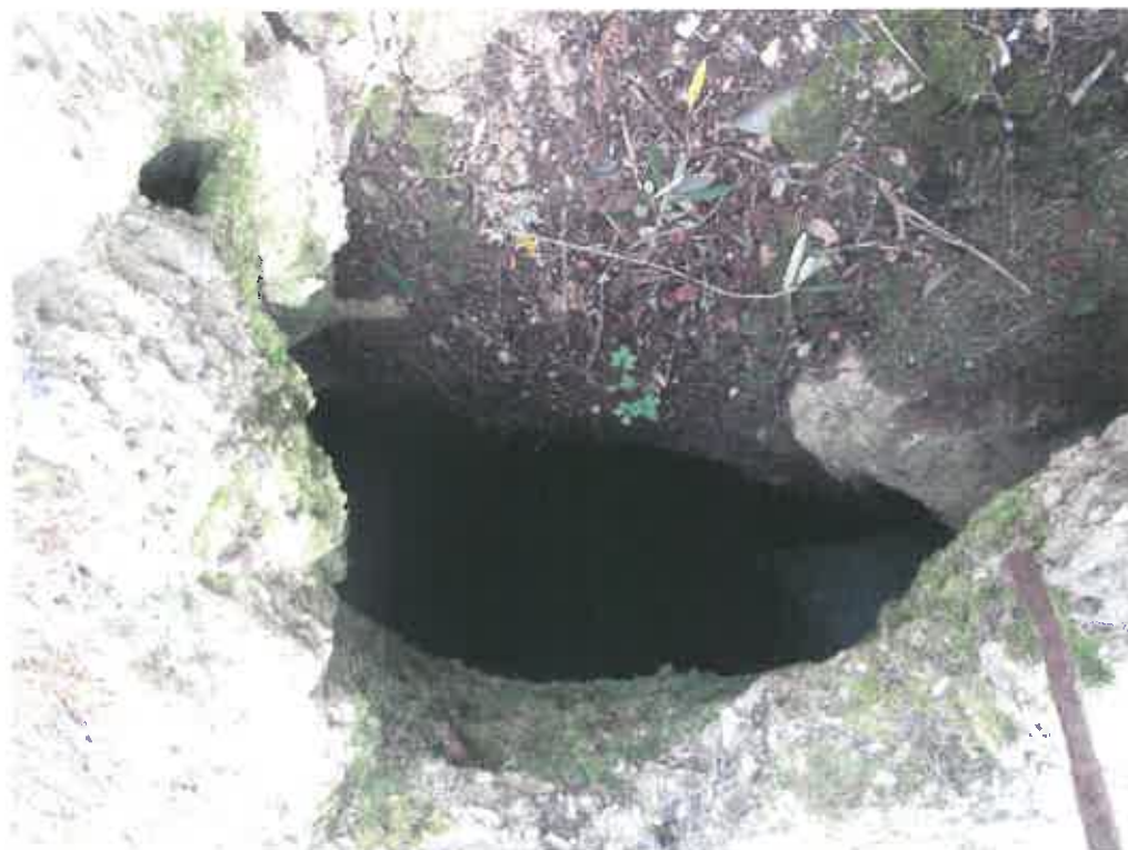
Figuras 36. Imagen de una de las fosas sépticas detectadas que conecta directamente con la Cova des Pas de Vallgornera.
