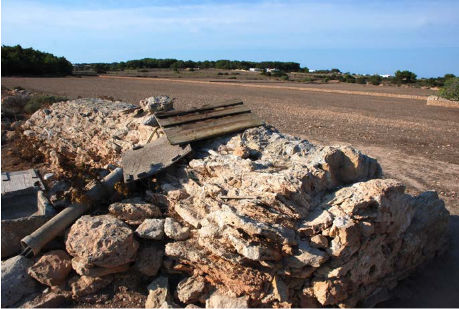
Imatge 1. Aljub d'en Rita, venda de sa Talaïassa, Formentera. És l'únic que no presenta capella i l'aigua s'extreu per la trapa original.
