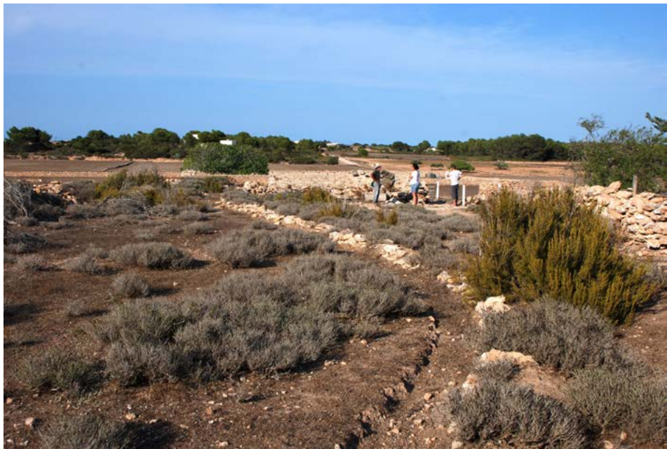
Imatge 3. Aljub d'en Rita. Condicionament del terreny circumdant per conduir l'aigua a l'aljub.
