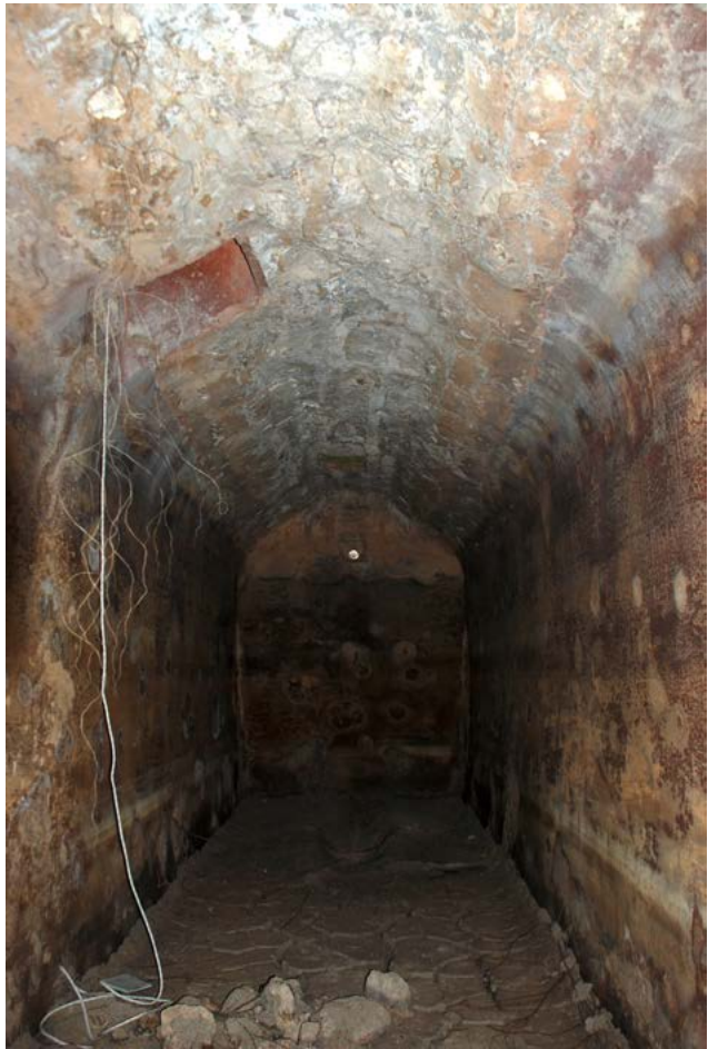
Imatge 8. Interior de l'aljub d'en Xomeu Maians, venda de sa Talaiassa, amb l'orifici d'entrada d'aigua i la trapa de la capella. Al centre de la volta es conserva, condemnada, la trapa original.
