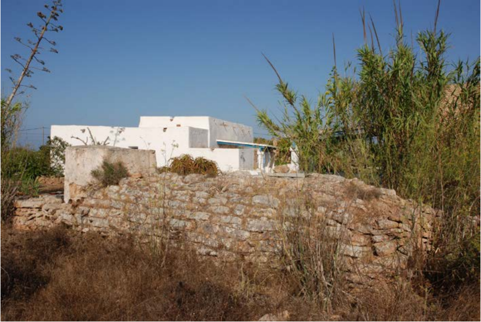
Imatge 5. Aljub d'en Jaume Costa, venda des Monestir, Formentera. S'hi veu l'extradós de la volta, fet de pedra escairada.
