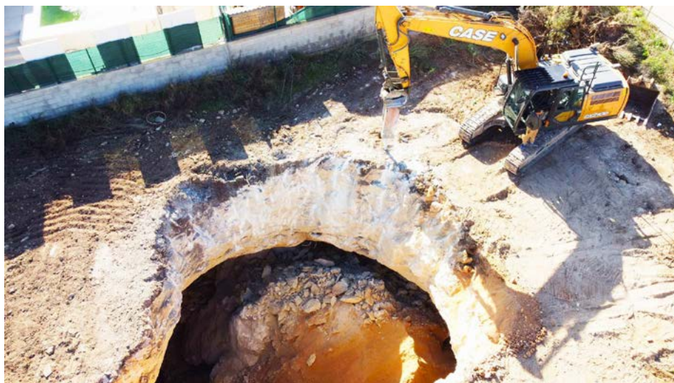
Figura 4. Vista aèria de les obres d'obertura de la cavitat efectuada amb maquinària pesant.
