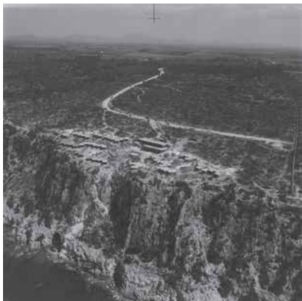
Fig. 1. Vista aèria d'El Dorado durant l'execució de les obres, TAF Helicòpters, 1966. Procedència: ANC / Fons TAF Helicòpters, S. A.
