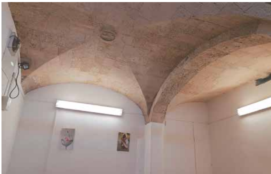
Interior de l'antic edifici de la Quartera. Fotografia de l'autora.
