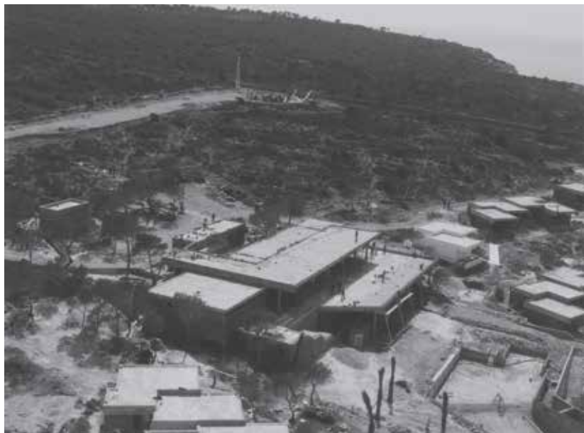
Fig. 2. Vista aèria de l'edifici social d'El Dorado durant l'execució de les obres, TAF Helicòpters, 1966. Procedència: ANC / Fons TAF Helicòpters, S. A.
